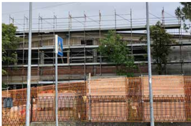
Foto2: lavori scuola primaria "Eroi del Piave" giugno 2024
